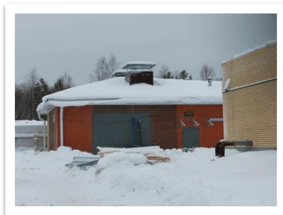
Посещение строительной площадки специального учреждения, Исакогорский округ г. Архангельска
